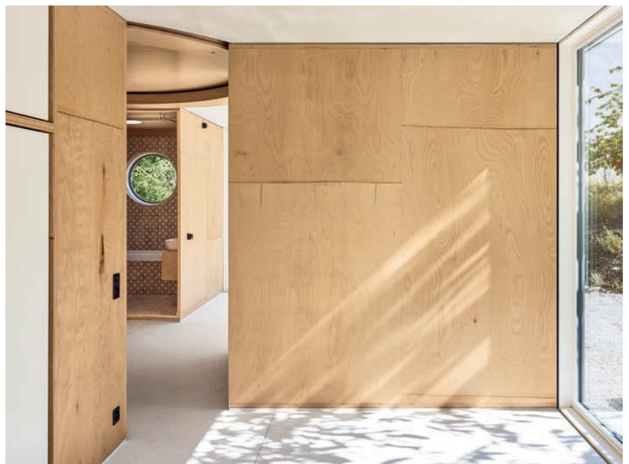
Das Möbel ist die Tragstruktur: Regale aus vier Zentimeter dünner Baubuche tragen das Dach.
